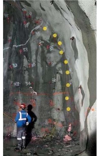
Рисунок 4 – Первый взрыв (MVC-024), заряженный рассредоточенным по длине зарядом 0,6 кг/п.м.; четвертый взрыв (MVC-027) часть периметра справа заряжена ЭВВ по технологии String Loading 0,6 кг/п.м. и 1,2 кг/п.м., соответственно
