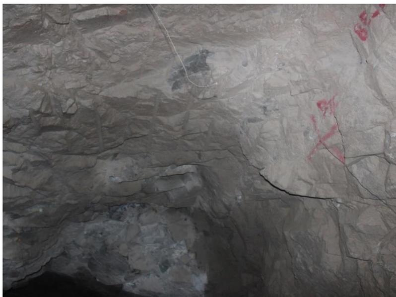
Рисунок 25 – Результаты опытного взрыва - кровля выработки при применении контурного взрывание
