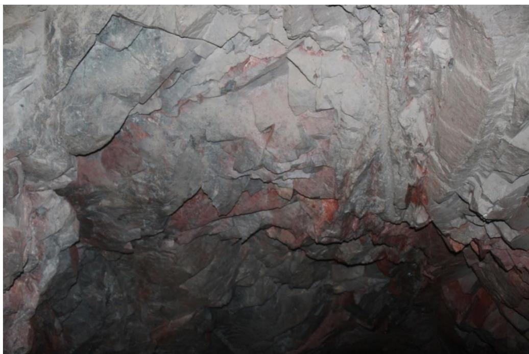
Рисунок 24 – Результаты опытного взрыва – кровля выработки при обычном взрывании
